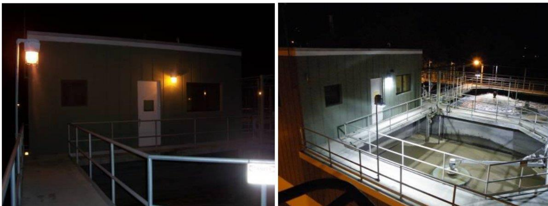
Figura 5. Ambiente industrial antes e depois da mudança na iluminação por projetores LED.
