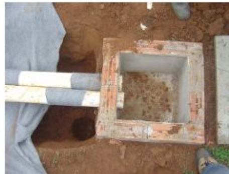
Figura 4 – Detalhe do dispositivo de extravasamento de vazões excedentes.
