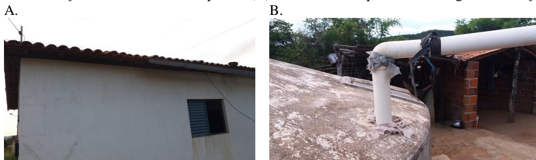
Figura 3. Utilização das calhas de forma parcial (A); Uso de sacolas plásticas ao longo da tubulação (B).
