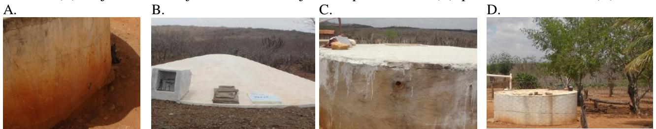
Figura 7. Patologias no armazenamento: Fissuras e trincas no corpo da cisterna (A); Porta de visita com avaria (B); Objetos sobre a laje/Trincas entre a laje e o corpo da cisterna (C); proximidade de árvore (D)
