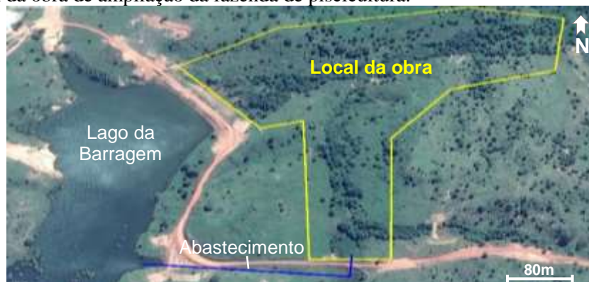
Figura 1. Local da obra de ampliação da fazenda de piscicultura.
