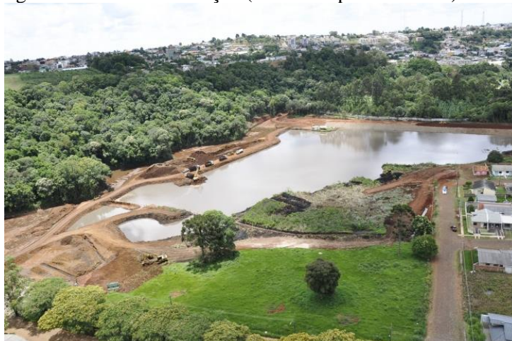
Figura 3. Bacia de contenção (Fonte:Grupo Zancanaro)
