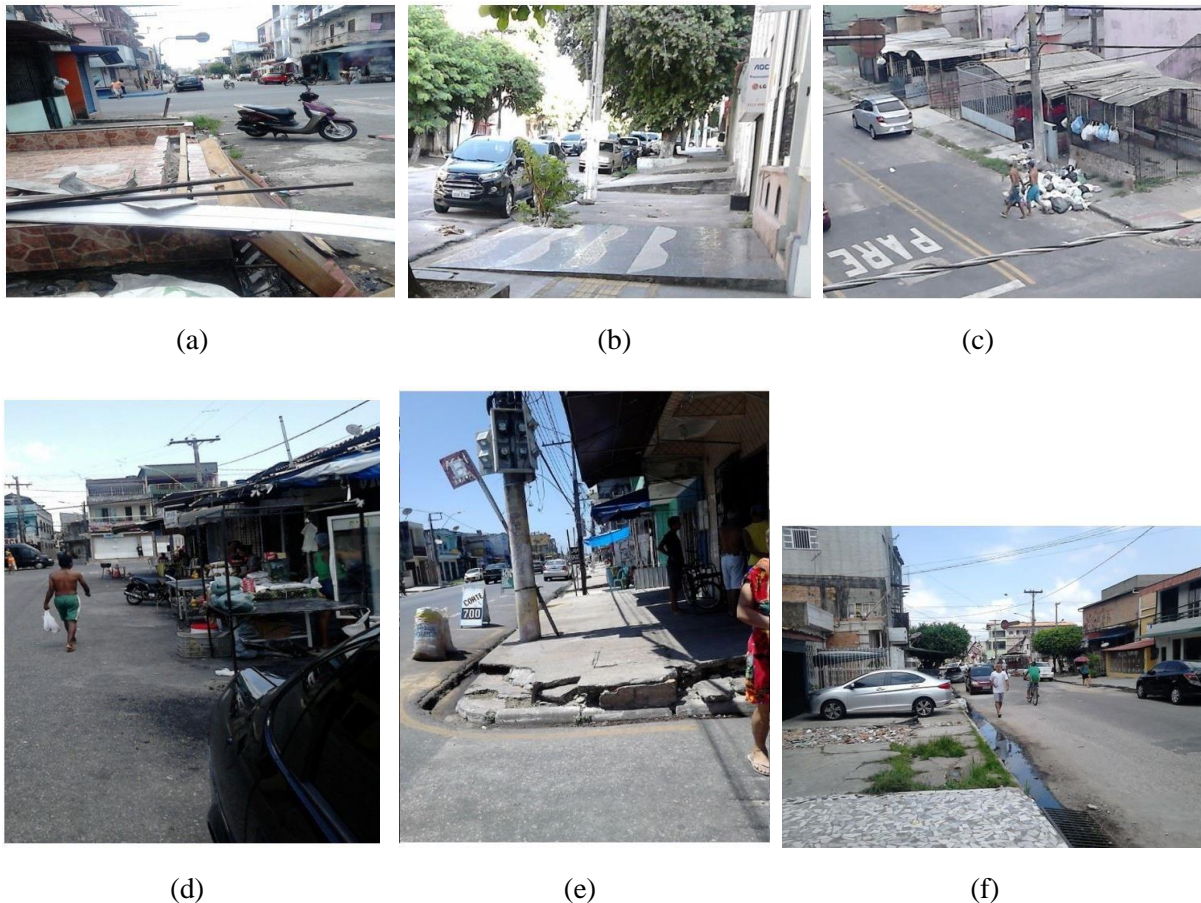
Figura 3. Exemplos de problemas na periferia (a) obras irregulares; (b) desníveis; (c) lixo doméstico; (d) ambulantes ocupando toda a calçada; (e) inexistência de rebaixamento na travessia de pedestres; (f) carro estacionado na faixa livre e buracos.
