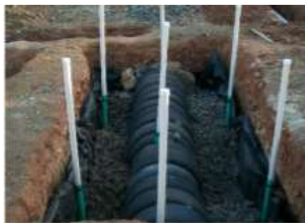
Figura 01 - Montagem da Unidade para receber a água cinza
