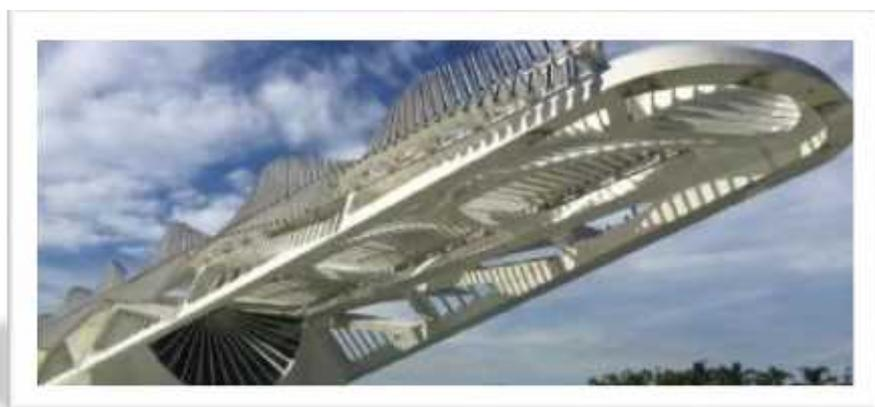
**Figura 1.** Vista parcial da envoltória do O Museu do Amanhã, no Rio de Janeiro, que incorpora elementos móveis com painéis fotovoltaicos, cujo posicionamento é ajustável para maximizar a incidência de radiação solar e sombreamento
