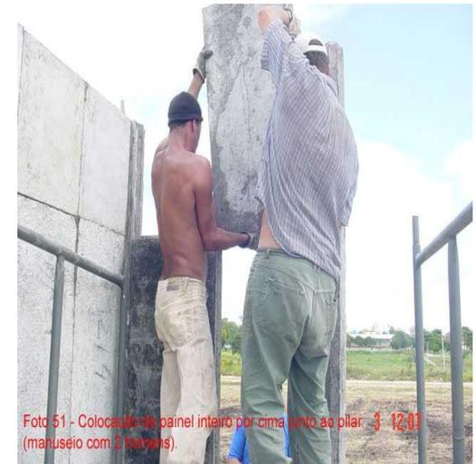
Foto 51 - Colocação de painel inteiro por cima junto ao pilar. 3 12 07 (manuseio com 2 homens).
