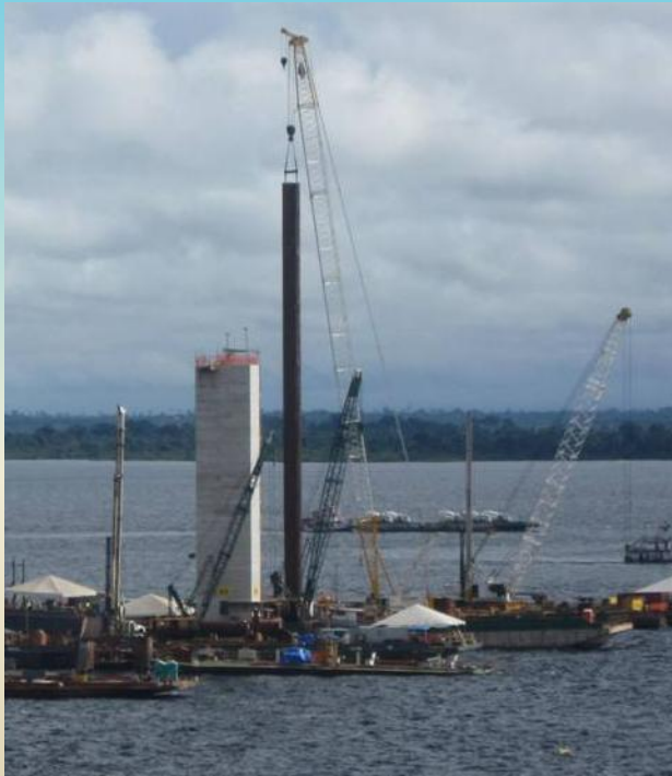
Içamento e posicionamento da camisa metálica
