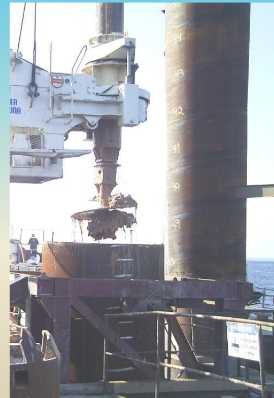
Trado para atravessar camadas de rocha
