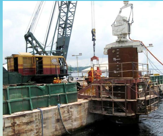
Cravação com vibrocravador
