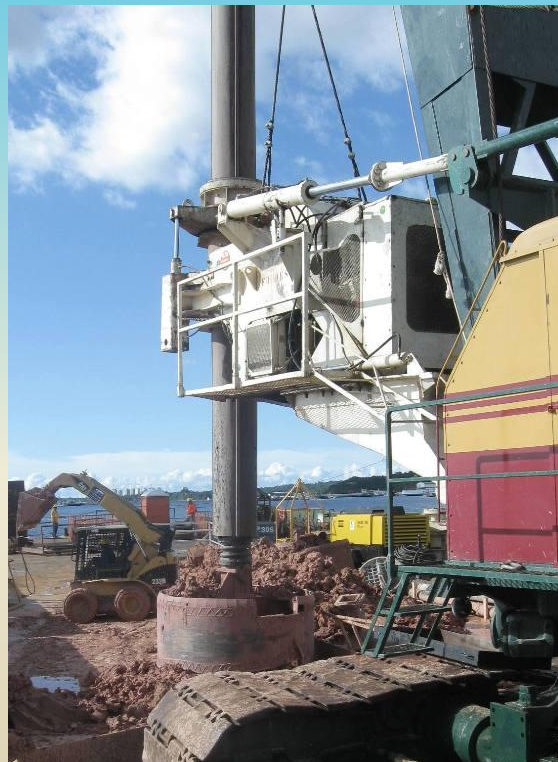
Escavação em solo
