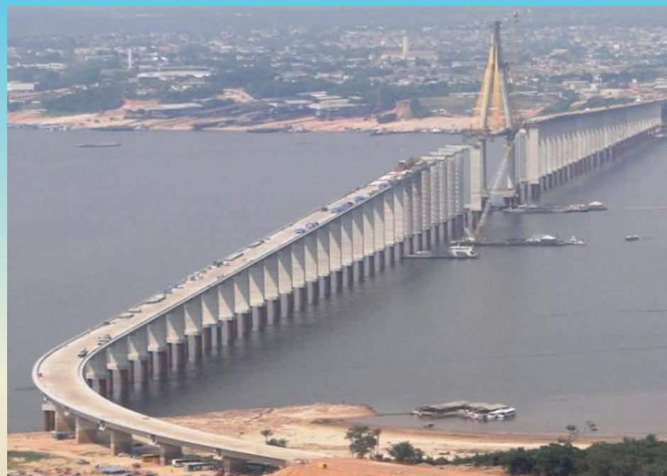
Ponte sobre o rio Negro - AM
