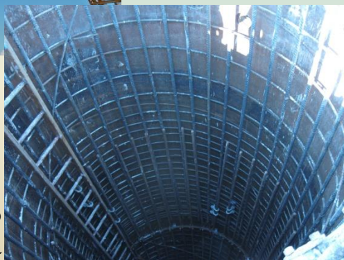
Armadura dentro da camisa
