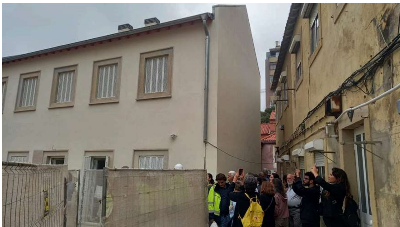
Figura 3 - Visita Técnica Vila Romão
