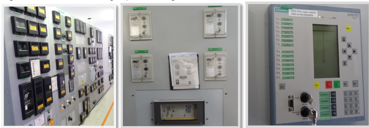
Figura 3 - Relés das diversas gerações tecnológicas.
