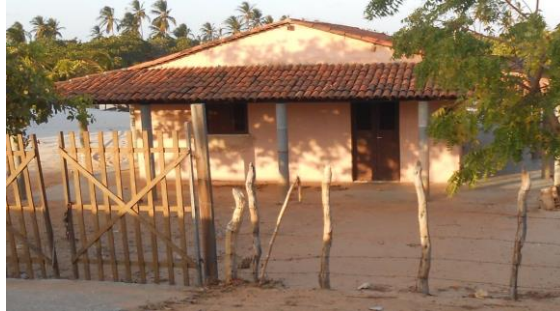
Figura 3. Casa de alvenaria com modelo similar a de taipa de pequeno porte em Icapuí-CE, 2016.
