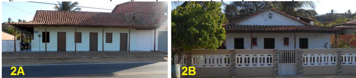
Figura 2. Modelo de casa de taipa de grande porte (2A) e de pequeno porte (2B). Icapuí-CE, 2016.
