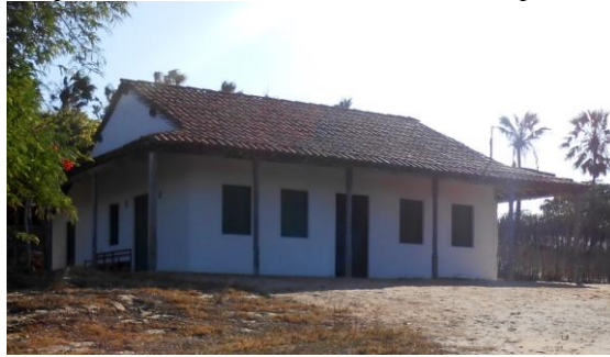
Figura 1. Casa centenária de taipa na comunidade de Ibicuitaba. Icapuí-CE, 2016
