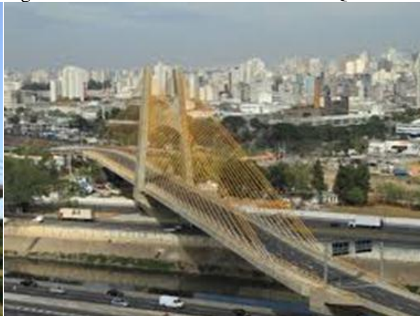
Figura 02 - Ponte Estaiada Gov. Orestes Quércia
