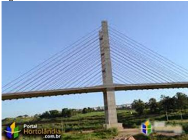
Figura 01 - Ponte Estaiada de Hortolândia
