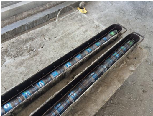
Figura 4 – Alvéolos introduzidos na armação
