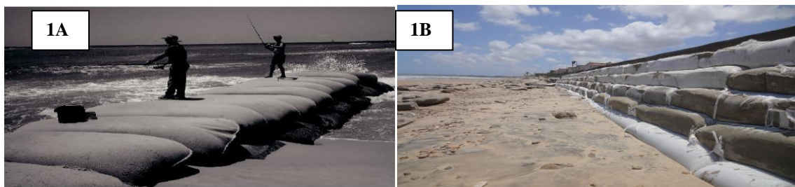
Figura 1. 1A) Bagwall: saco geotêxtil; 1B) Bawgall na praia do Icarai.
