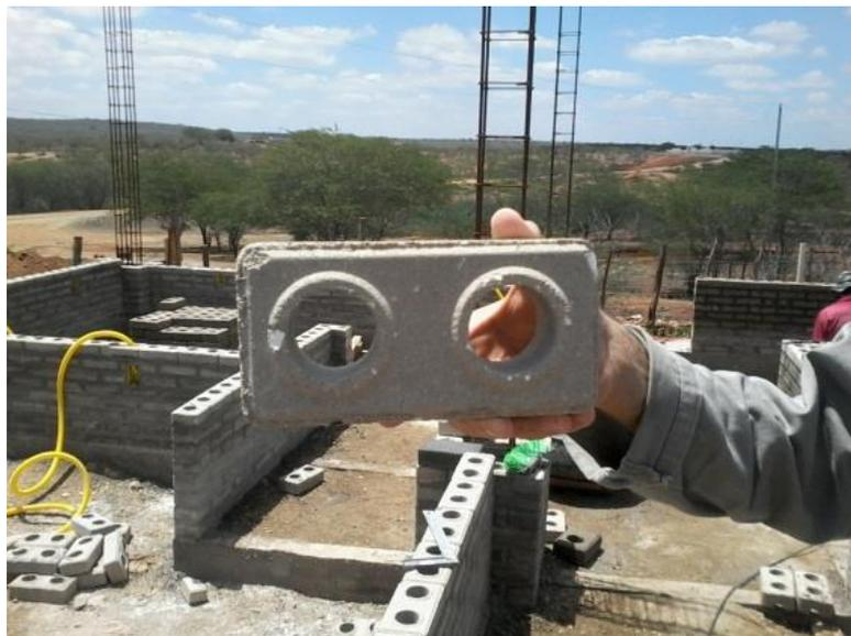
O uso de material em solo-cimento não ficou restrito ao serviço na alvenaria. Esta técnica foi utilizada, com muita eficiência, na fundação tipo sapata corrida, bem como na camada de regularização do piso, que recebeu posteriormente revestimento em cerâmica esmaltada na cor branca. O emprego do material em solo-cimento serviu para reduzir acentuadamente o custo final da habitação.
