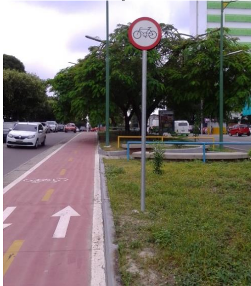
Figura 6 – Sinalização Vertical – Placa de Circulação Exclusiva de Bicicletas.
