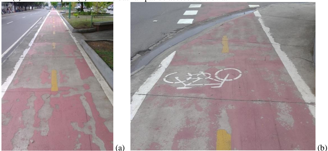
Figura 4. (a) Pintura no piso (b) Detalhe das rampas de acesso à ciclovia.
