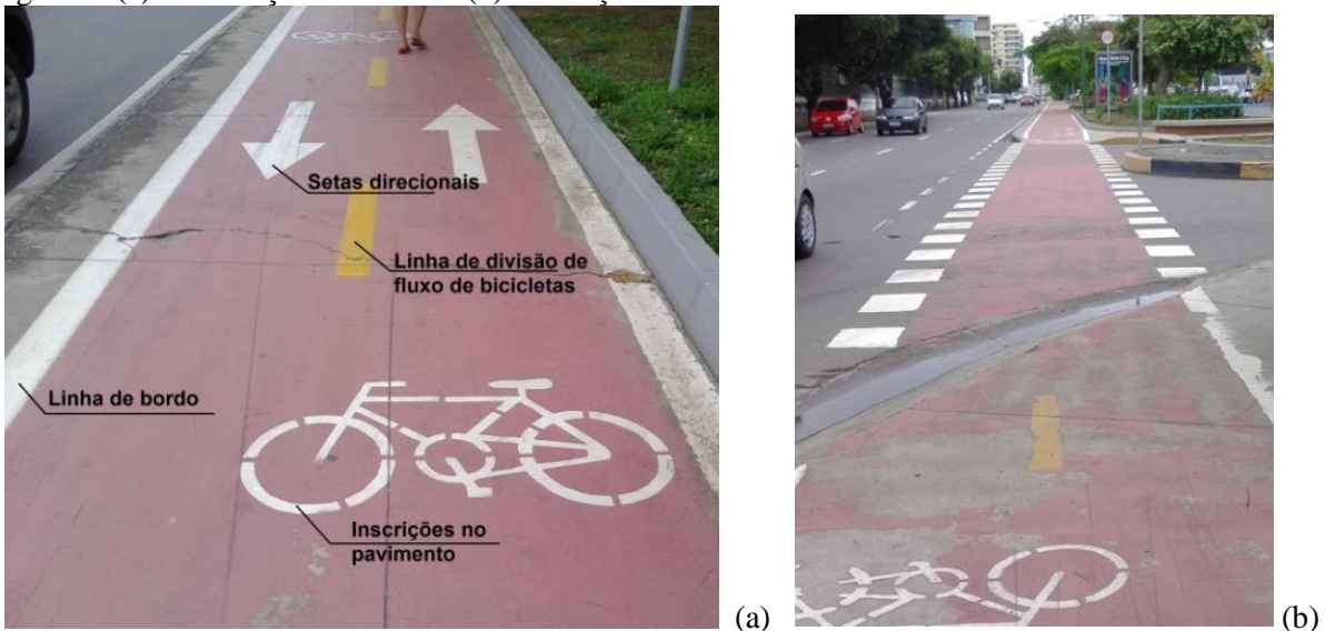
Figura 5. (a) Sinalização Horizontal (b) Marcação no cruzamento.
