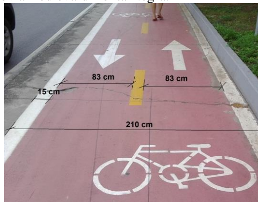
Figura 2. Dimensões da Ciclovia Boulevard-Ponta Negra.
