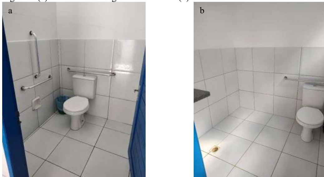
Figura 2. (a) Banheiro de uso geral masculino e (b) banheiro acessível.
