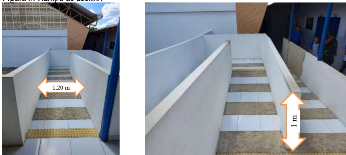
Figura 3. Rampa de acesso.
