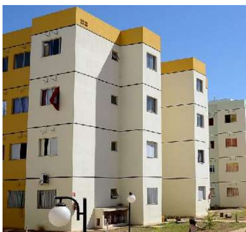
Figura 2 - Edificações padrão em alvenaria estrutural
