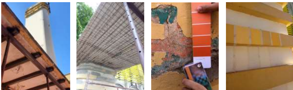
Figura 3. Sustentação da laje antes da restauração; escarificação da laje; prospecção cromática
