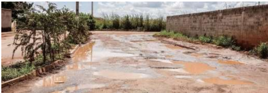
Figura 1 - Rua 11, setor Industrial
