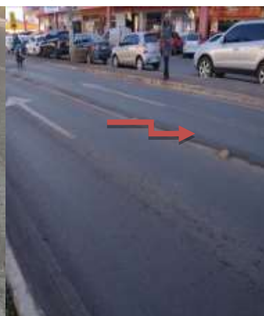
04 Trinca Longitudinal Curta - Trinca Longitudinal Longa - Trinca Interligada
