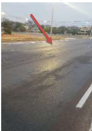
04 Trinca Longitudinal Curta - Trinca Longitudinal Longa - Trinca Interligada
