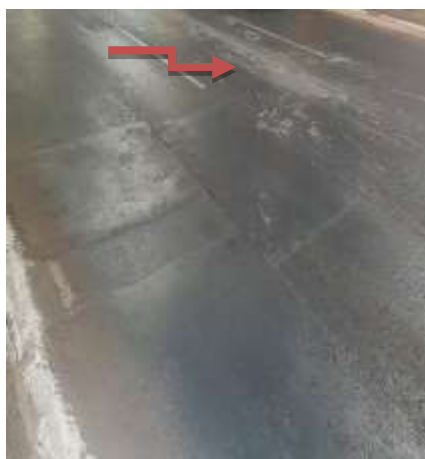
04 Trinca Longitudinal Curta - Trinca Longitudinal Longa - Trinca Interligada
