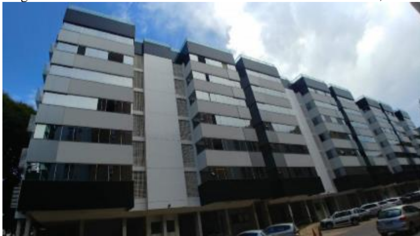
Figura 1 – Edifício da Asa Norte em Brasília – DF. Fonte: Autor, 2020.
