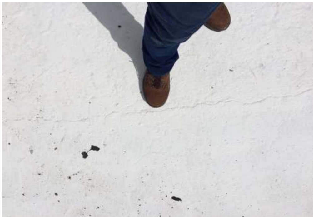
Figura 3 – Fissura na Laje
