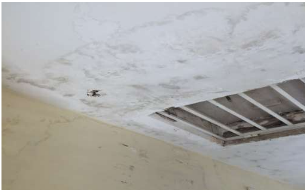
Figura 3 – Fissura na Laje
