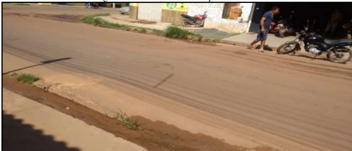
Figura 3. Lombada sem sinalização horizontal.
