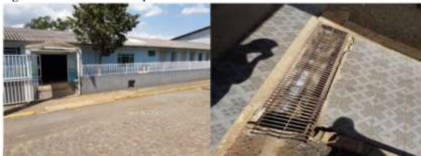
Figura 1. Acesso a edificação
