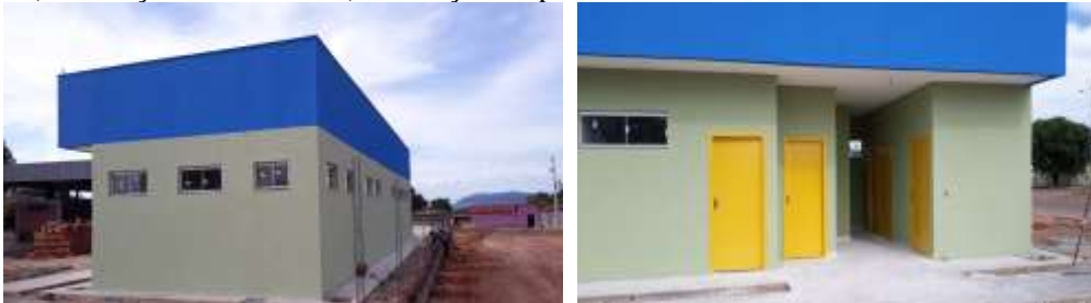
Figura 5. a) Execução de textura; b) Execução de pintura externa
