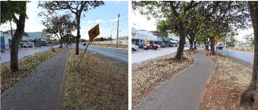
Figura 4- Análise das condições da Via M1 Sul (sinalização vertical)
