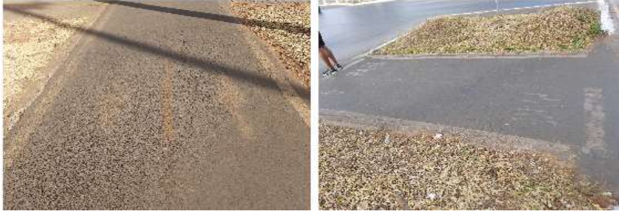
Figura 31- Análise das condições da Via M1 Sul (sinalização horizontal)
