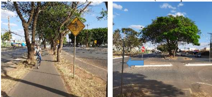
Figura 7- Análise das condições da Via M1 Norte (sinalização vertical)
