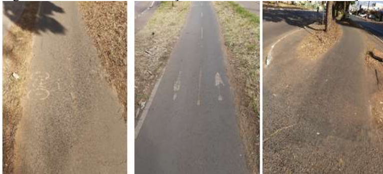
Figura 63 - Análise das condições da via M1 Norte (sinalização horizontal)
