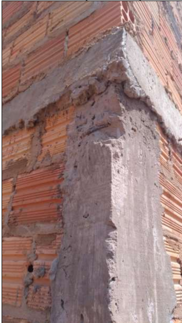
Figura 4. Vista de armaduras expostas e falha no processo executivo.
