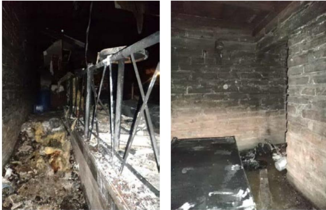
Figura 1. Corredor de saída com 1,00 metro de largura e circulação de acesso para a saída (CREA-RS, 2013).
